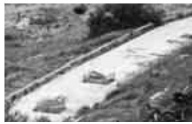
I LAVORI IN VIA PANORAMICA DEI TEMPLI
